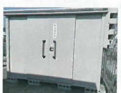
会館屋上設置
